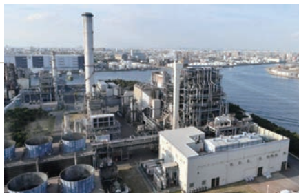
東亜石油 水江発電所
